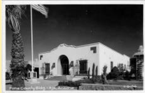
7-D-50, Pima County Bldg.-Ajo, Arizona
