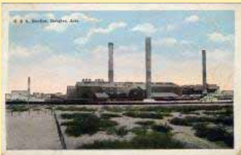
14963 C. & A. Smelter, Douglas, Ariz.
