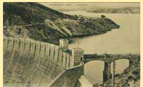
Roosevelt (5) Dam, Arizona.
