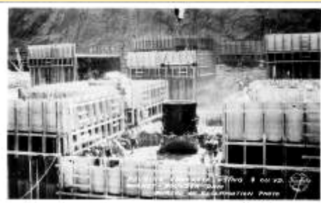
Pouring Concrete Using 8 Cu. Yd. Bucket
