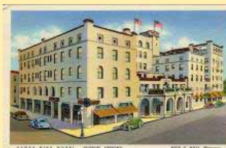
9A-H112 Santa Rita Hotel, Tucson, Arizo
